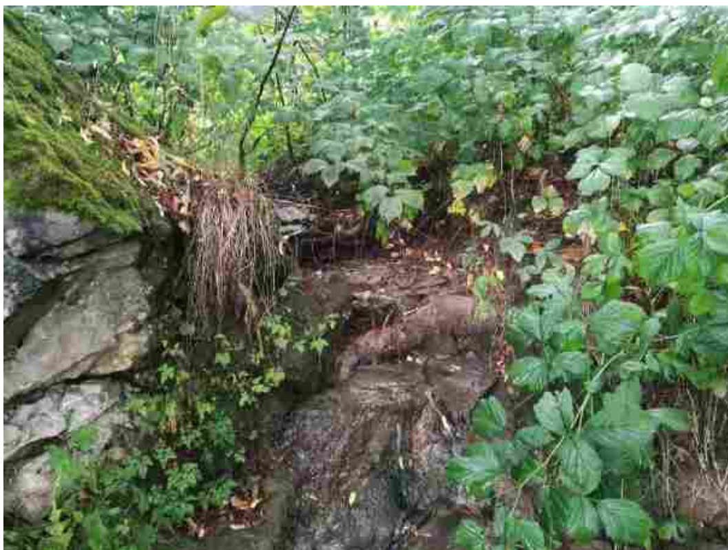
FOTOGRAFIA 2 WIDOK NA PRZELEW OD STRONY WODY DOLNEJ.
