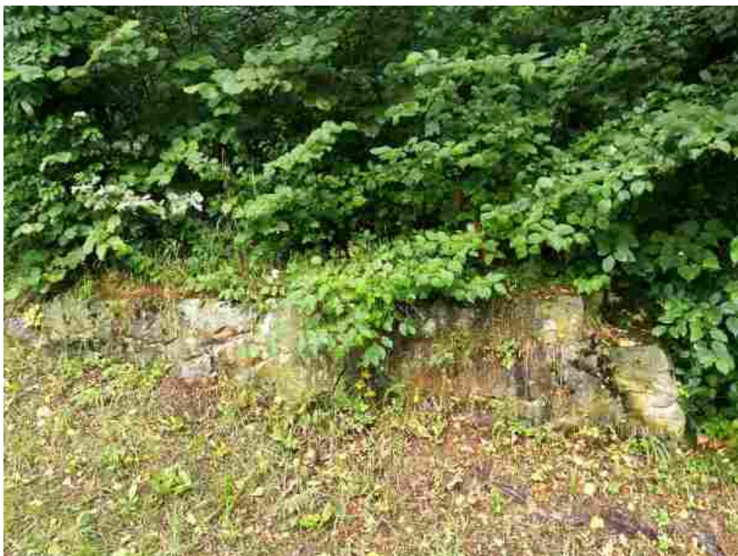
FOTOGRAFIA 6 WIDOK NA SKRZYDŁO BOCZNE ZAPORY.
